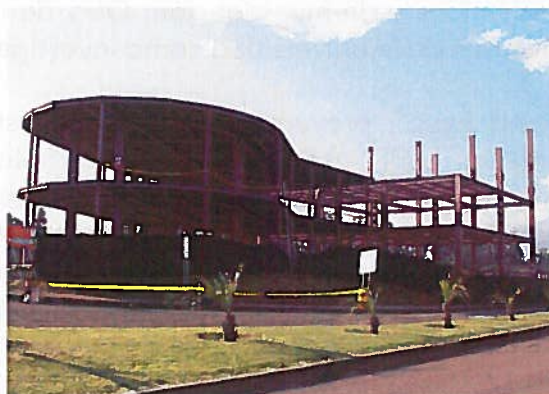
Edificación del Centro de Investigación y Posgrado
